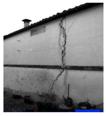
Una fessurazione del tipo detto "di trascinamento" sulla parete di un edificio, è sintomo di un fenomeno franoso in attività
